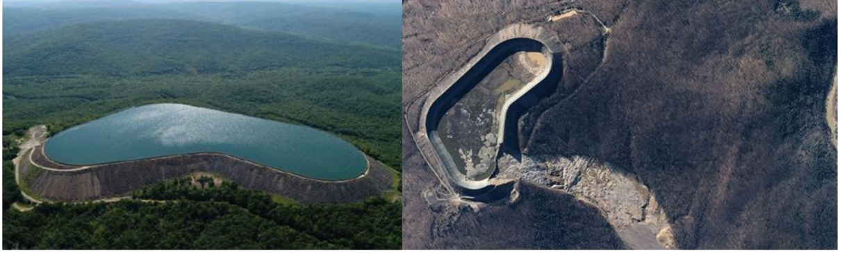
Tauk Sauk depolama alanının arıza öncesi ve sonrası görünümü
