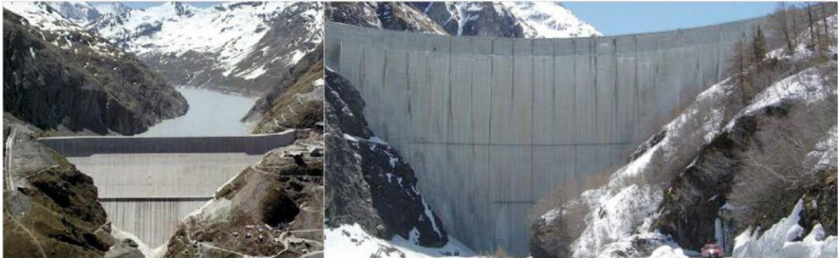
Şekil-1: Solda görülen 285 metre yüksekliğindeki 1961 yılında yapımı tamamlanan Grande Dixence barajı dünyanın en yüksek beton barajıdır. Sağda görülen 250 metre yükseklikteki Mauvoisin (Kötü Komşu) çift eğimli barajın yapımı ise 1957 yılında tamamlanmıştır. Her iki baraj da 50 yıldır kesintisiz olarak hizmet vermeyi sürdürmüştür.
